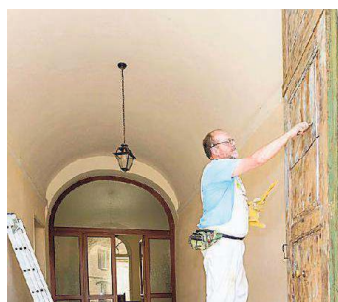
I lavori in via Frattini
